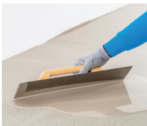
Aanbrengen van Ultraplan Contract
