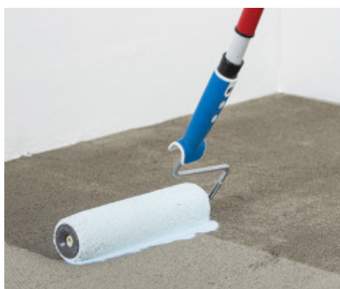
Aanbrengen van de primer op de ondergrond
