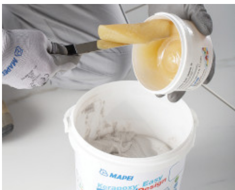
Giet de verharder (component B) in de emmer met component A
